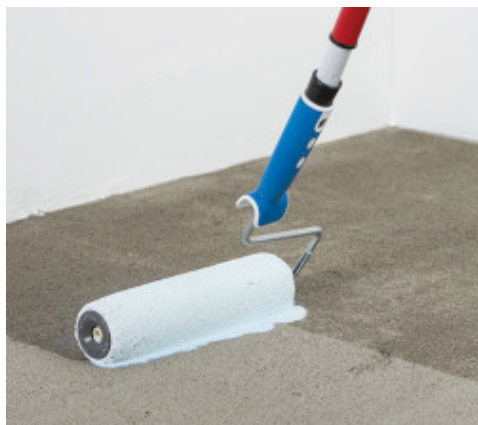
Applicazione di primer sul supporto
